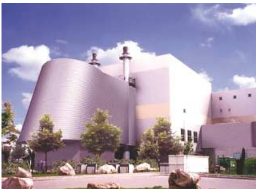
L'usine d'incinération de Saint-Thibault-des-Vignes, projet de mise en place d'un nouveau système de filtration
