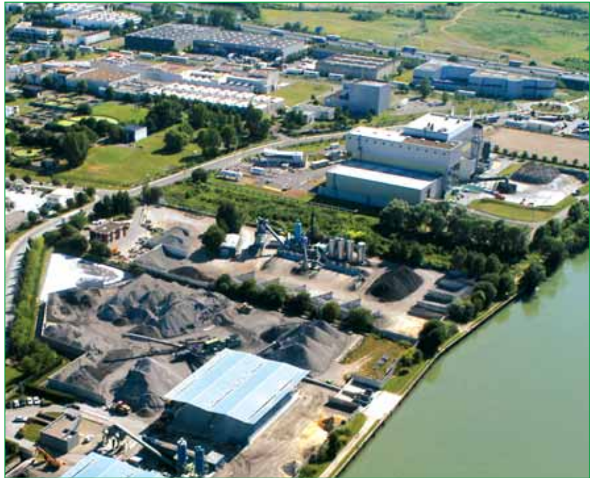
En récupérant et traitant les 33 000 m 3 d'eau utilisés sur le site, le Sietrem et Yprema contribuent à la protection de l'environnement.
