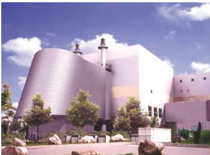
L'usine d'incinération de Saint-Thibault-des-Vignes, projet de mise en place d'un nouveau système de filtration
