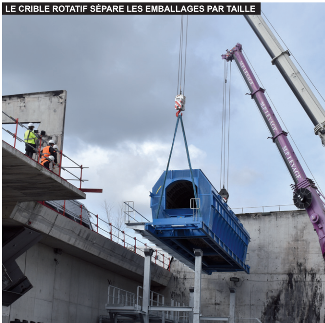
LE CRIBLE ROTATIF SÉPARE LES EMBALLAGES PAR TAILLE
